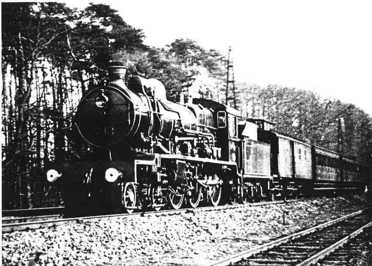
Photo ci-dessus : locomotive type 7 n° 743 à Boitsfort en 1935. Elle est munie de l'ACFI monté sur ce type de locomotives à partir de 1931. Photo : J.F. Van Puyvelde. Collection Ph. Dambly.
